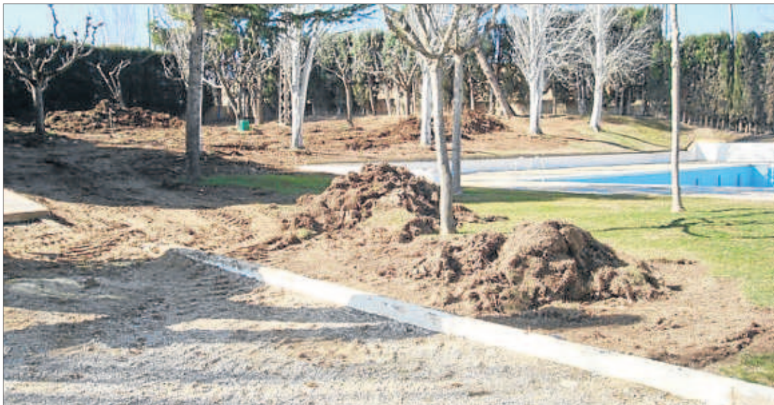
Les obres per a la renovació de la gespa de les piscines.
