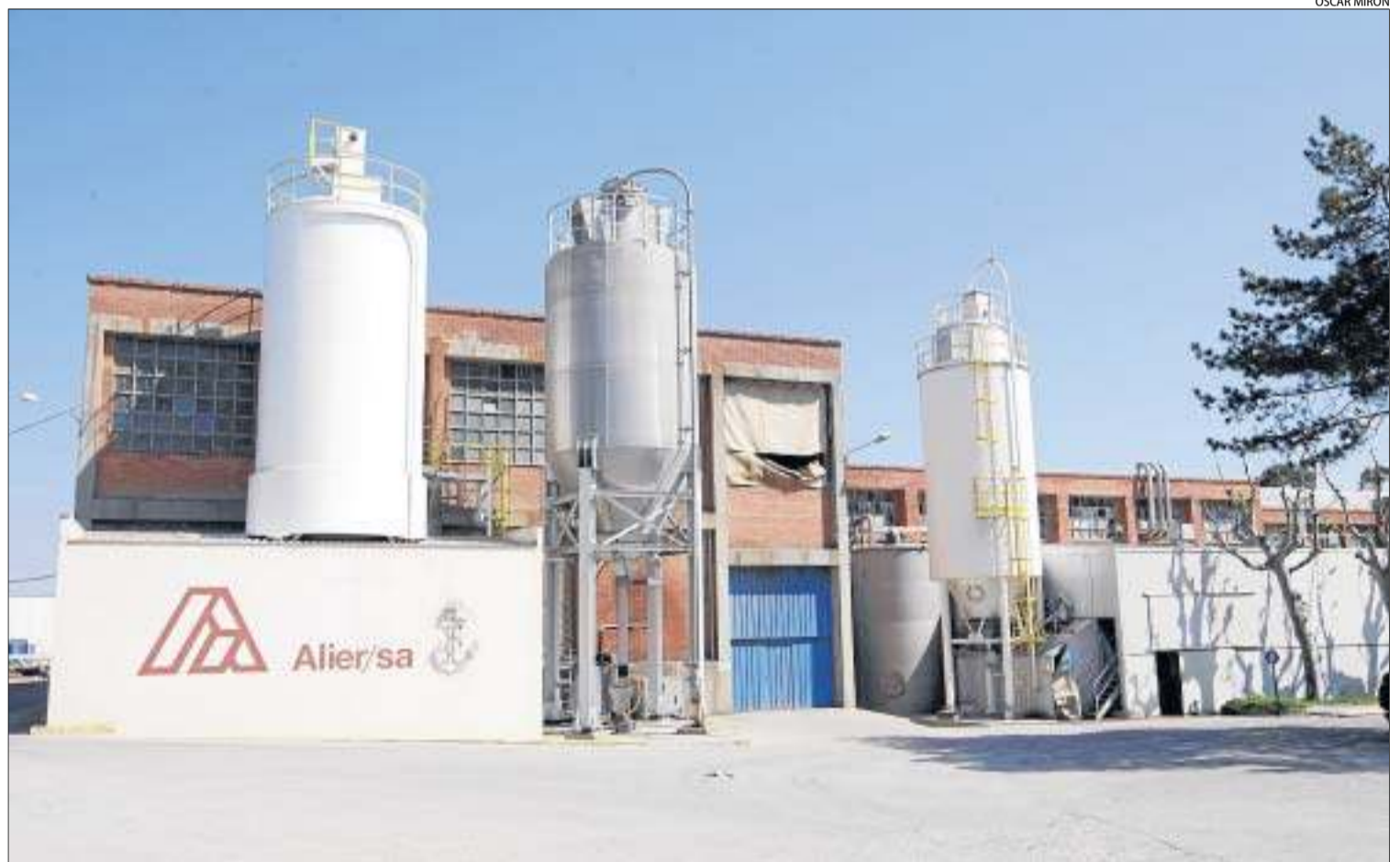
Les instal·lacions de la paperera situada a Rosselló van quedar paralizades des de dimarts passat per falta de subministrament de gas.
