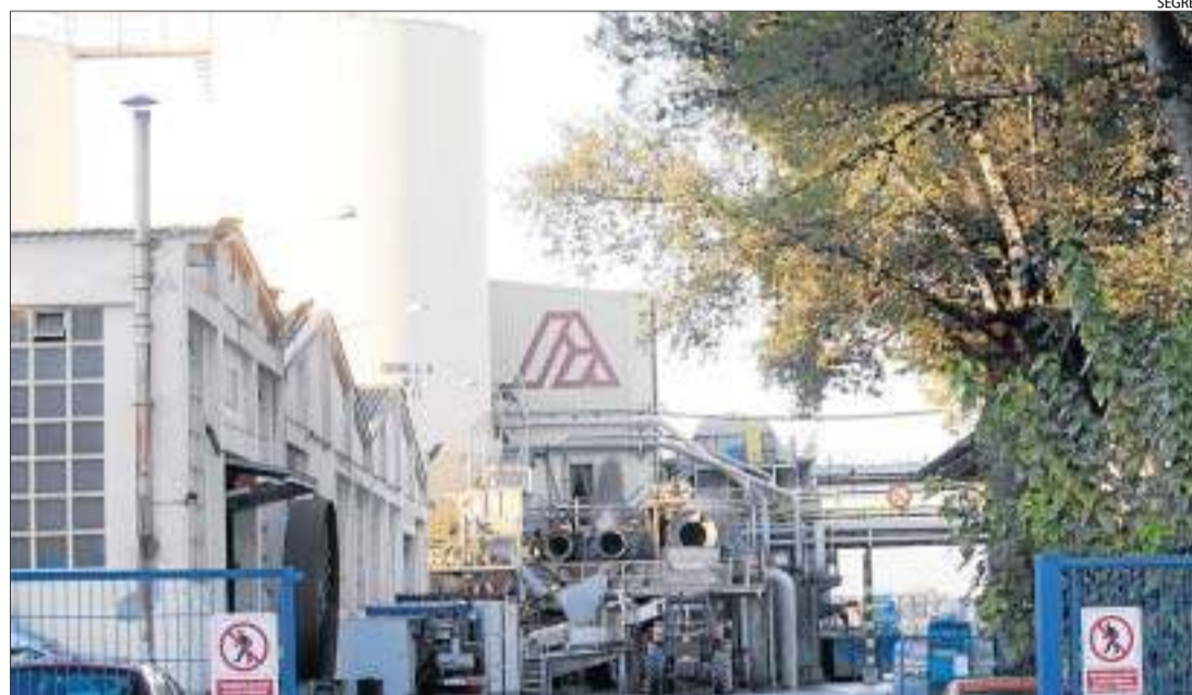
Vista exterior de les instal·lacions de la paperera Alier a Rosselló.
