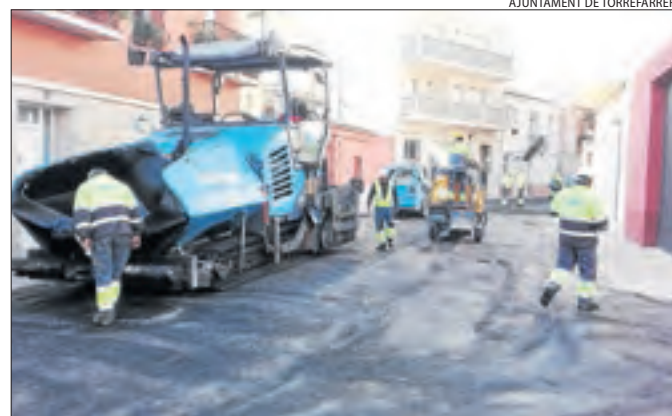
La zona de Torrefarrera on s'ha actuat.
