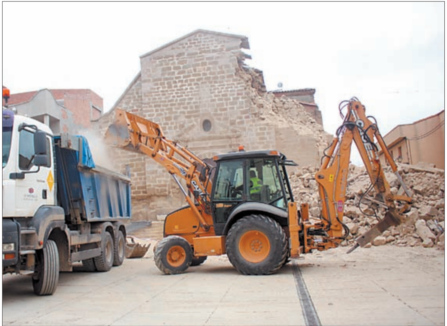
FOTO: Selena García / Imatge d'una excavadora fessant la runa al camió de l'empresa encarregada de netejar la plaça de l'Església
