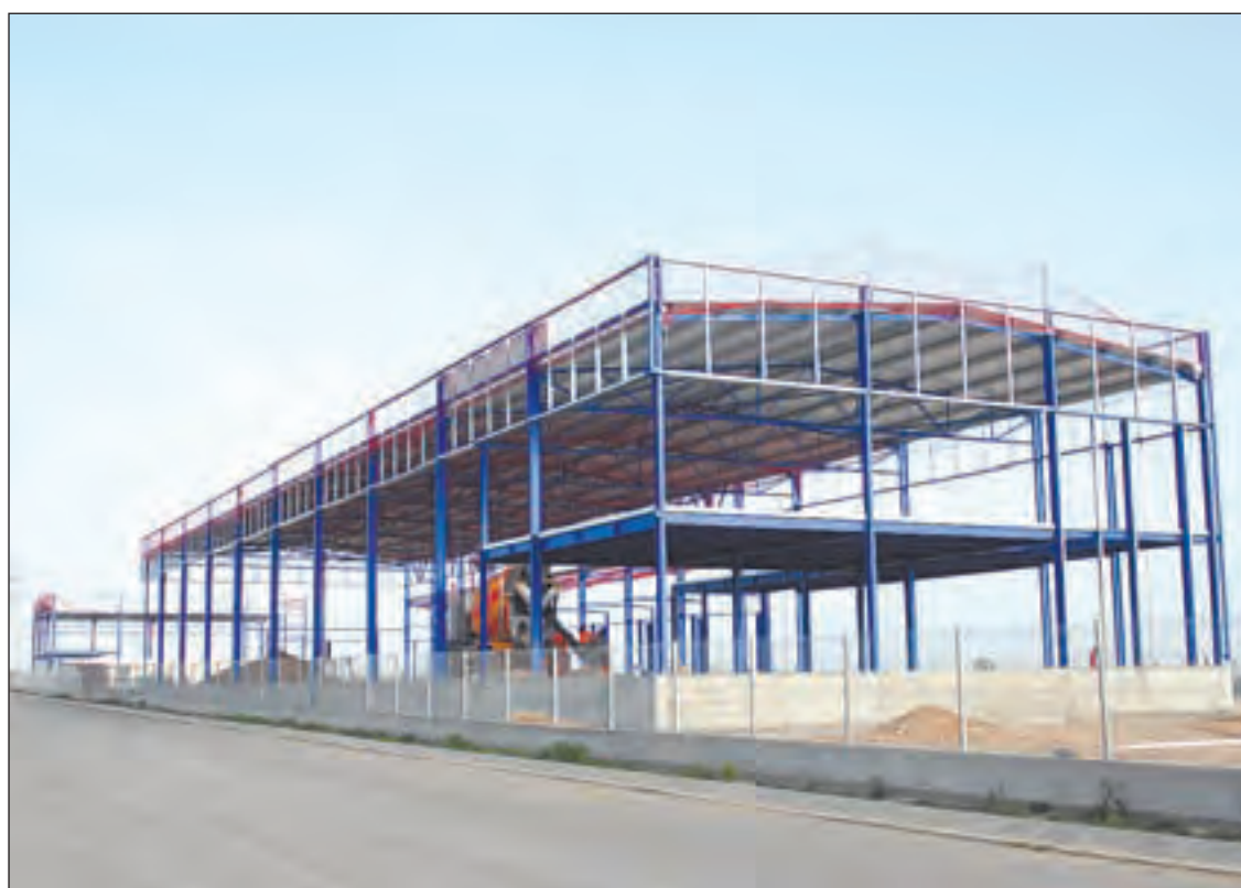
FOTO: Tony Alcántara / Una de les noves naus industrials que s'estan construint al polígon de Vilanova
