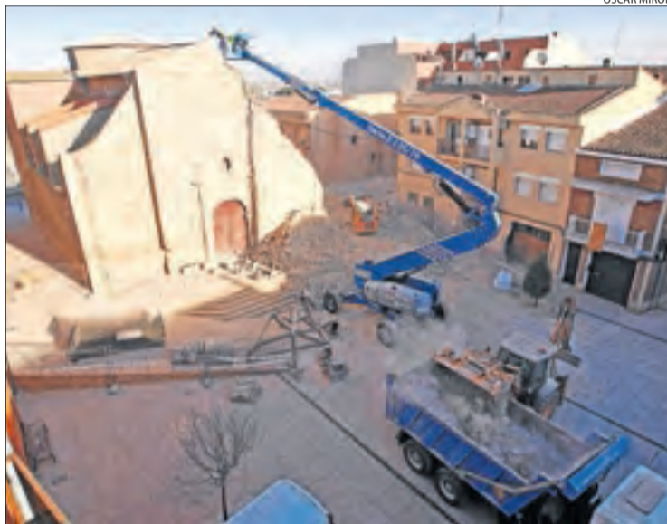
Treballs de sanejament de la façana de l'església.
