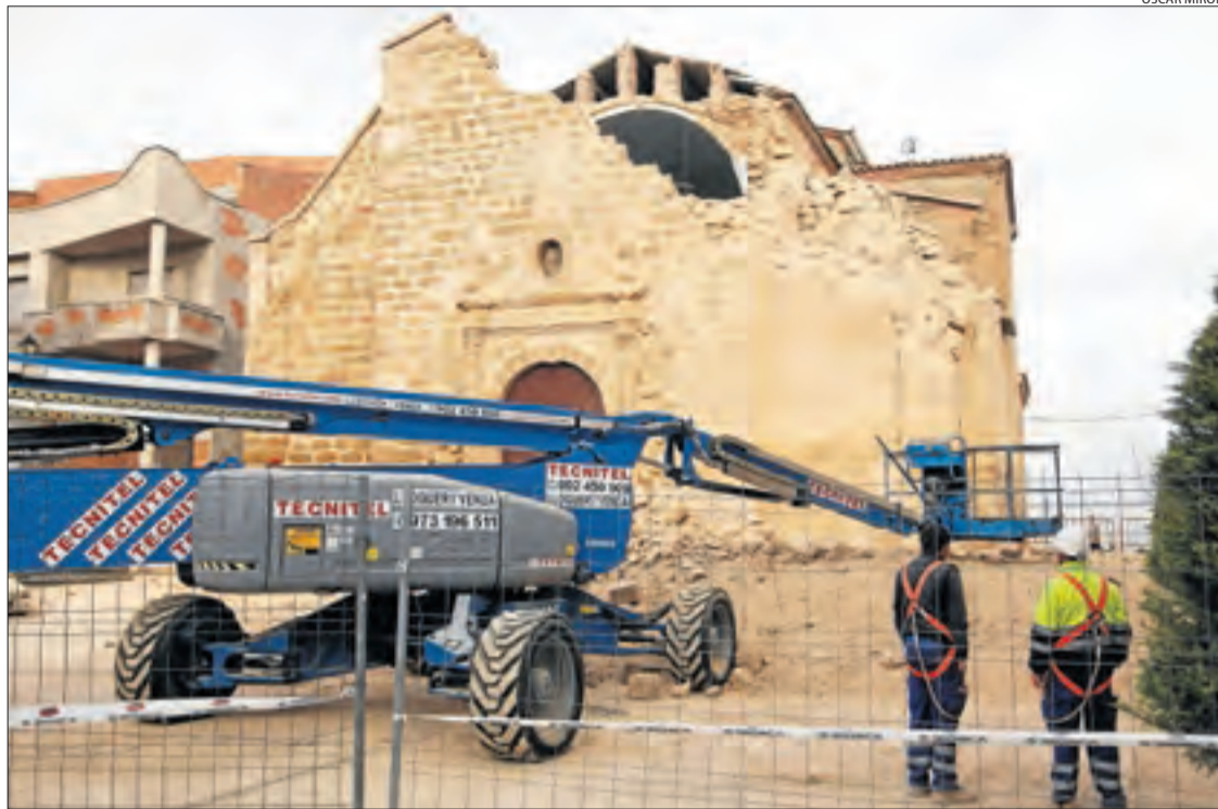
Part de la façana i de la coberta, enderrocada ahir per seguretat per l'esfondrament de la torre.
