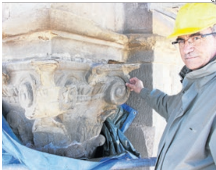
L'alcalde de Montgai, Jaume Gilibert, ahir comprovant les obres.
