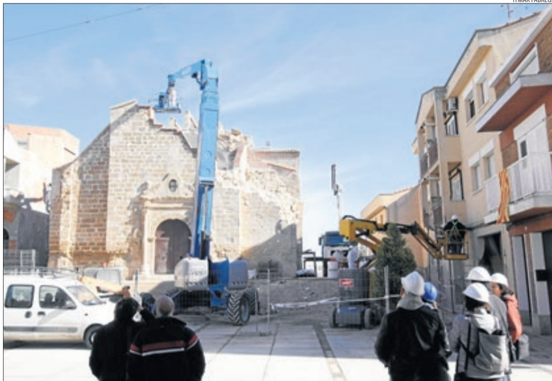
Treballs de consolidació de murs i parets, ahir a l'església parroquial de Rosselló.
