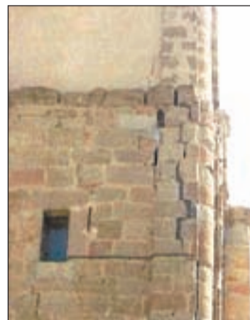
FOTO: Fotografia de les grans esquerdes ja a l'any 2004
