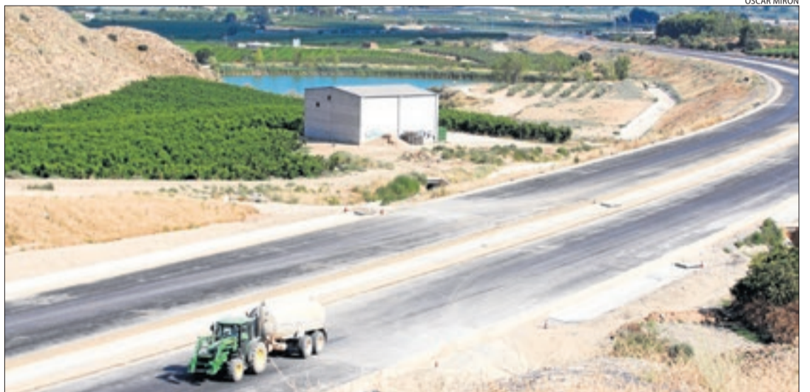
El tram d'autovia en obres al municipi de Torrefarrera.
