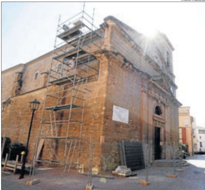
La bastida instal·lada per accedir a la teulada de l'església.
