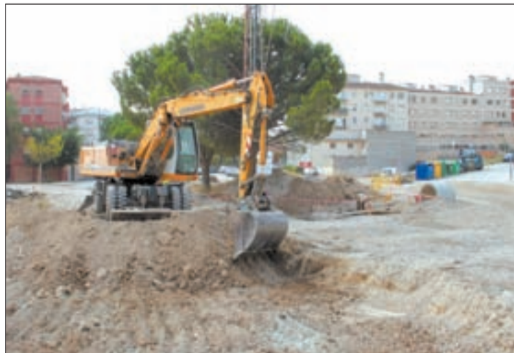
FOTO: Aj. de Tàrrega / Imatge de les obres a la Rambla del Canalet
