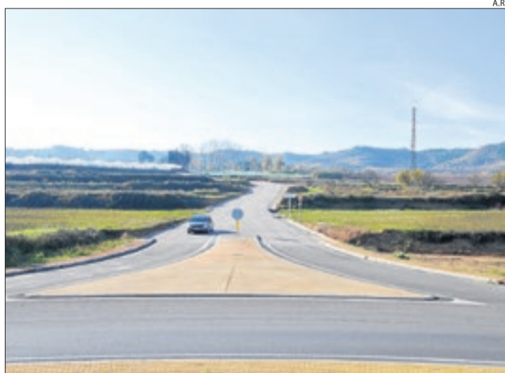
El nou vial que dona accés a la zona industrial de Rosselló.
