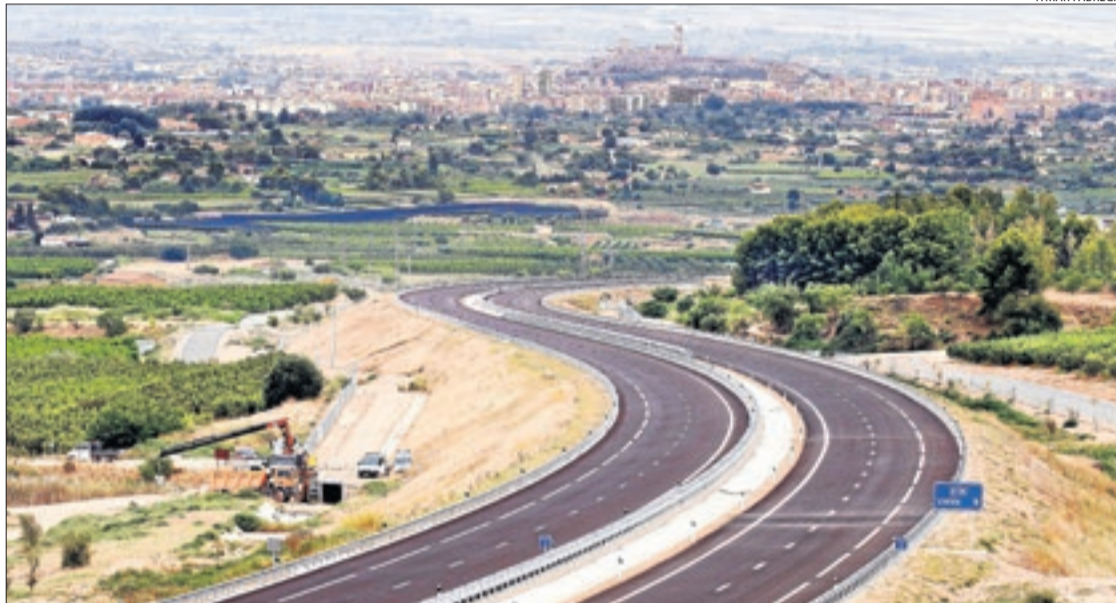
El nou tram de l'autovia A-14 entre Lleida i Rosselló.
