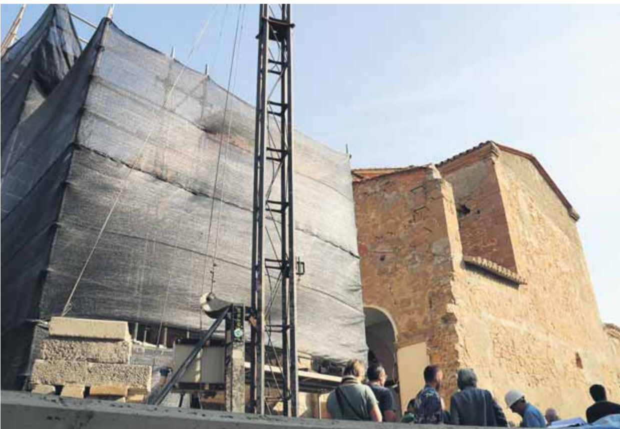
La façana principal de l'església està tapada per tal que es puguin fer els treballs ■ ACN
