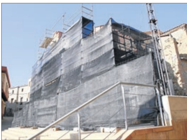
Imatge del dia que van començar les obres a l'església de Rosselló.
