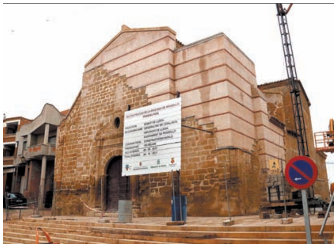
FOTO: ACN / La coberta ja s'ha arreglat però falta encara instal·lar el terra i pintar l'interior del temple
