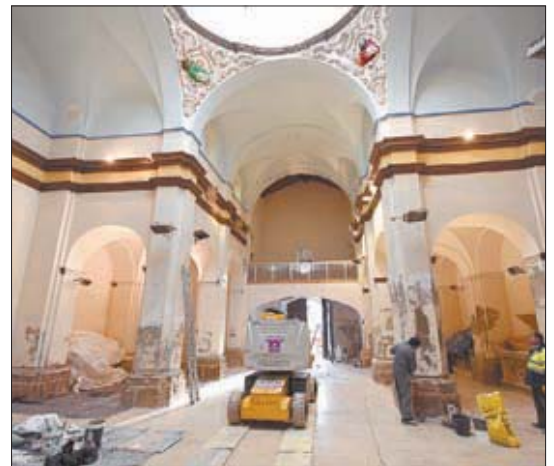
FOTO: Núria Garcia / Els operaris ultimant els treballs de l'interior de l'edifici
