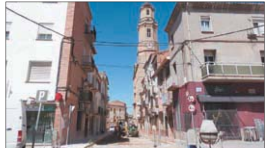
FOTO: Aj. Borges / Les màquines treballant als carrer Santa Vedruna
