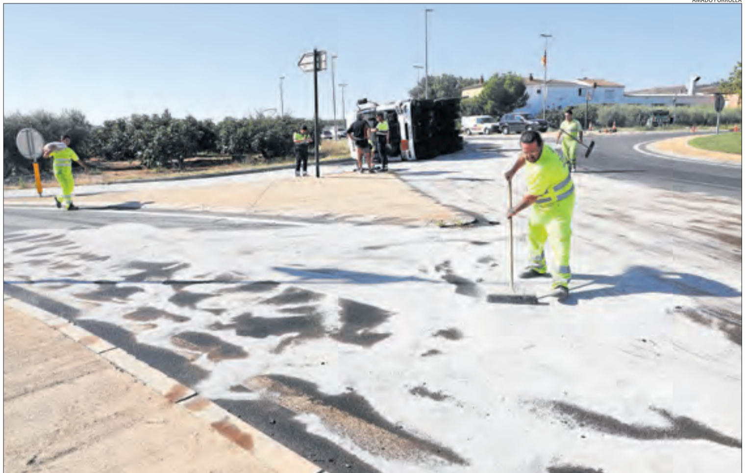
Operaris van tirar sorra sobre la carretera perquè absorbís el gasoil del camió cisterna, bolcat al fons de la imatge.
