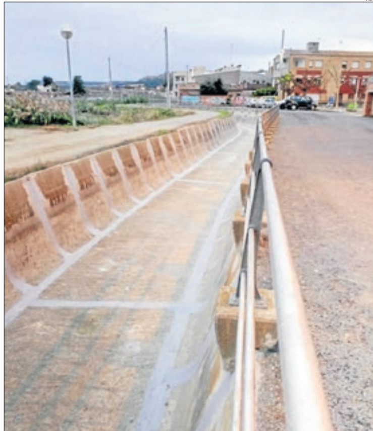
La reparació de la séquia del Cap que s'ha fet a Rosselló.
