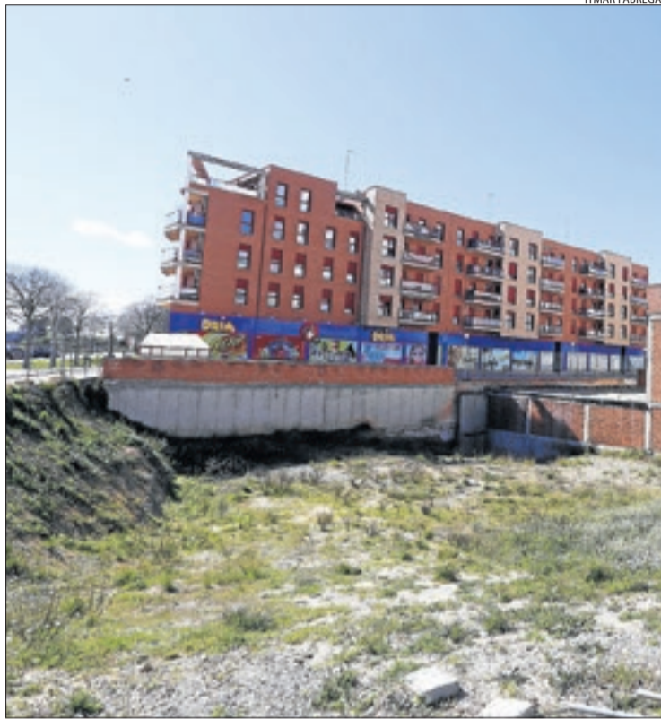
El solar on aniran els habitatges, entre l'LI-11 i Estudi General.
