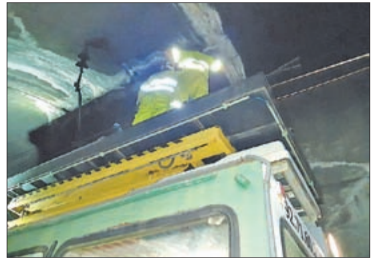
FOTO: Renfe/ Imatge dels tècnics arreglant l'avaría a la catenària
