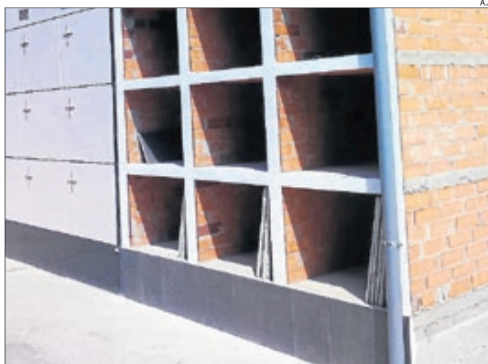
Les obres al cementiri d'Aitona.
