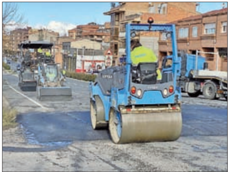
FOTO: Jordi Pascual/ Imatge de les obres que es fan al carrer Major
