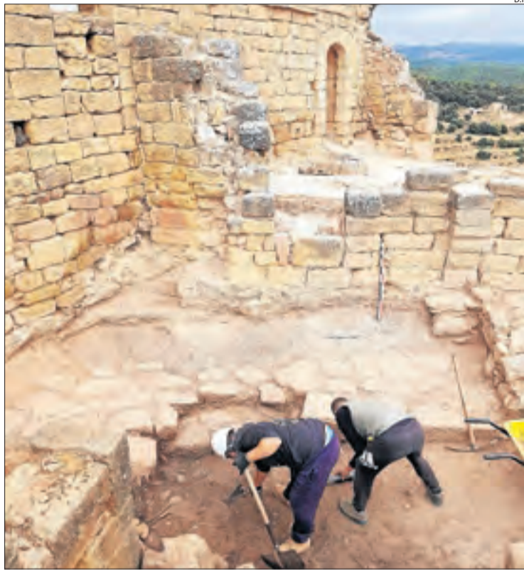
Primers treballs de restauració a la zona del castell.
