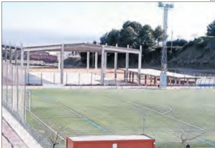
L'estructura del pavelló, que s'acabarà l'any que ve.
