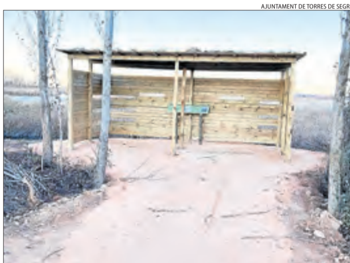
Una de les noves instal·lacions de la reserva natural d'Utxesa.
