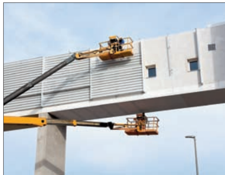
FOTO: Núria Garcia / Els operaris estan revestint la passarel·la
