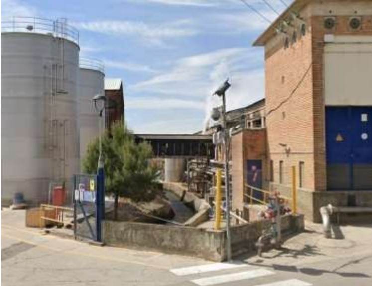
Fotografia 1.- Mostra la Sèquia Major del Canal de Pinyana, aigües avall del pont del vial del Camí de Benavent, en la qual pot apreciar-se a primer terme el desnivell existent entre aquest vial i els marges de la sèquia, la inexistència de camins de servituds i la presència en ambdós marges d'instal·lacions vinculades a l'activitat industrial.
