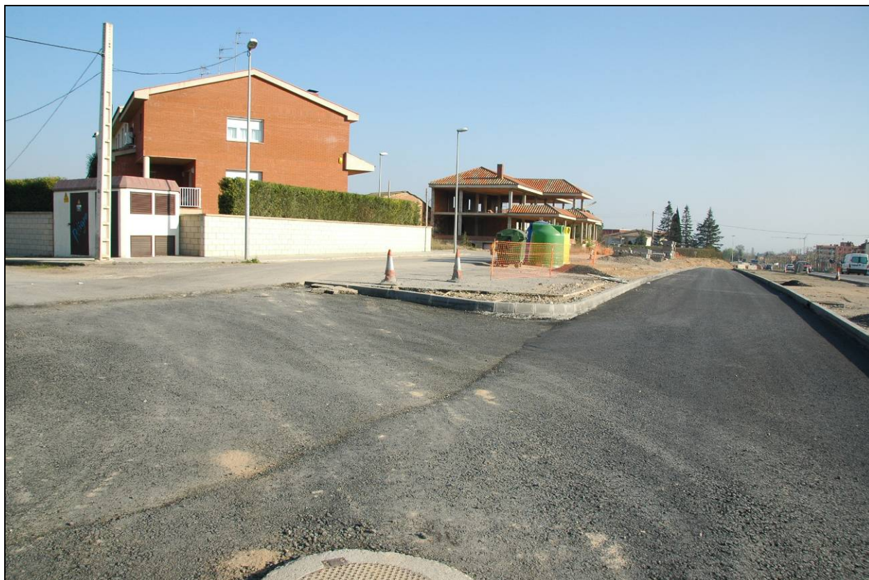
Carrer lateral N-230, des de la cantonada amb el carrer de l'edifici Sant Jordi
