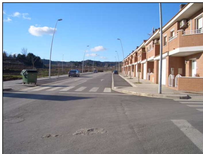
Prolongació del carrer Verge del Pilar. Font: Elaboració pròpia
