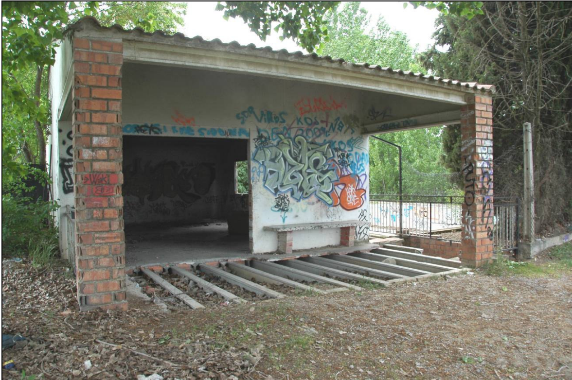
A: Magatzem, façana est
