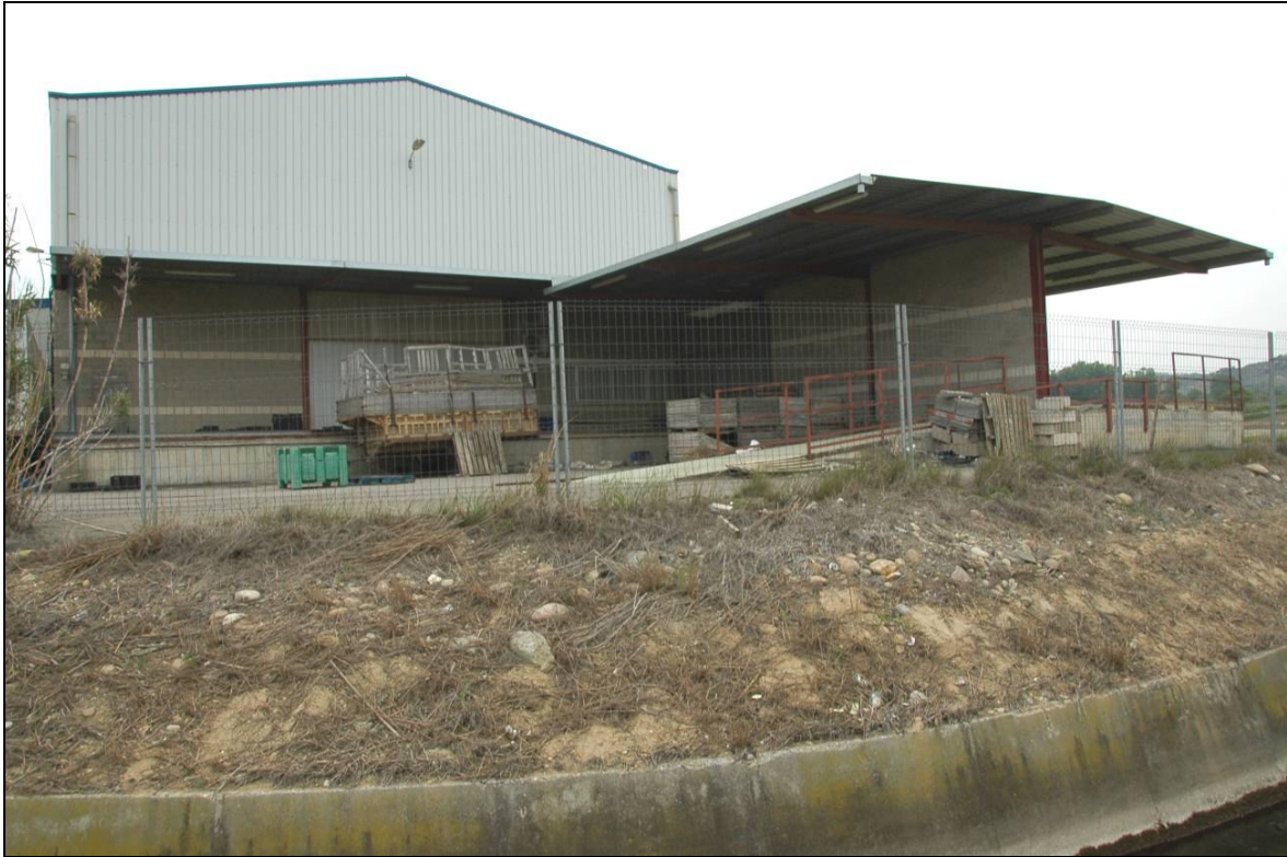
C: Coberta moll i mur que sustenta la coberta, Façana nord, des del Canal de Pinyana
