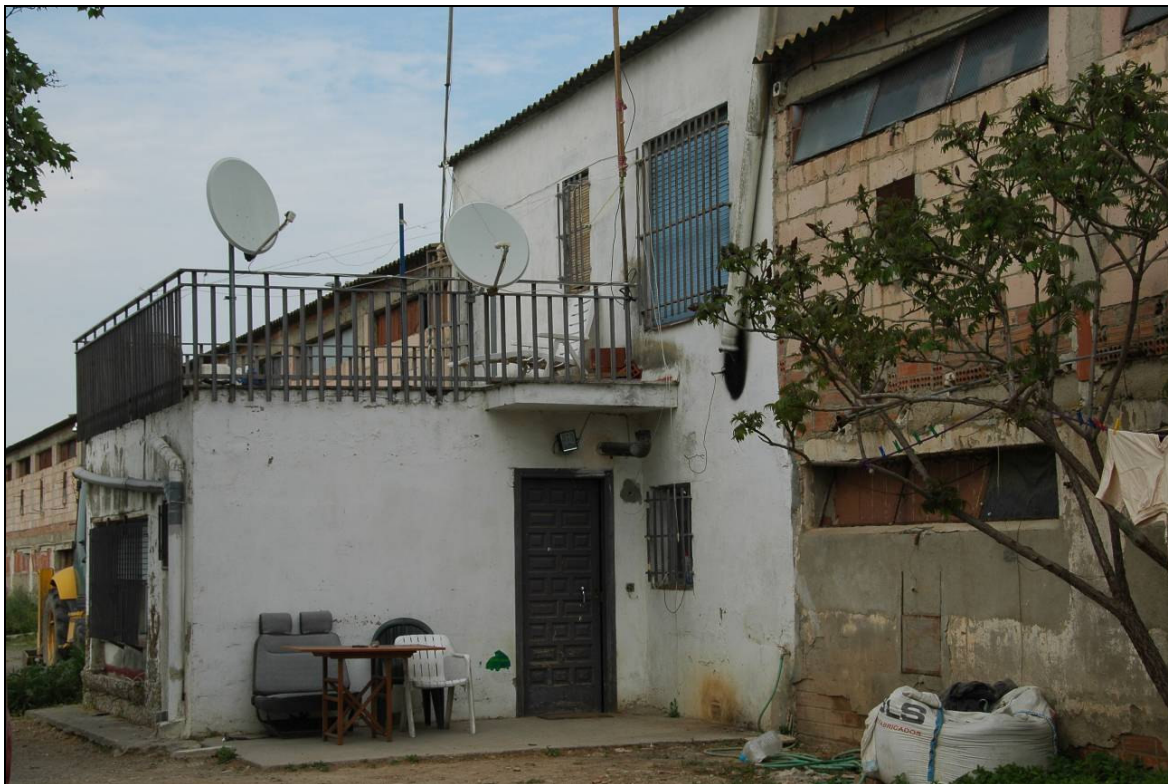
A: Habitatge, façana oest, entrada principal
