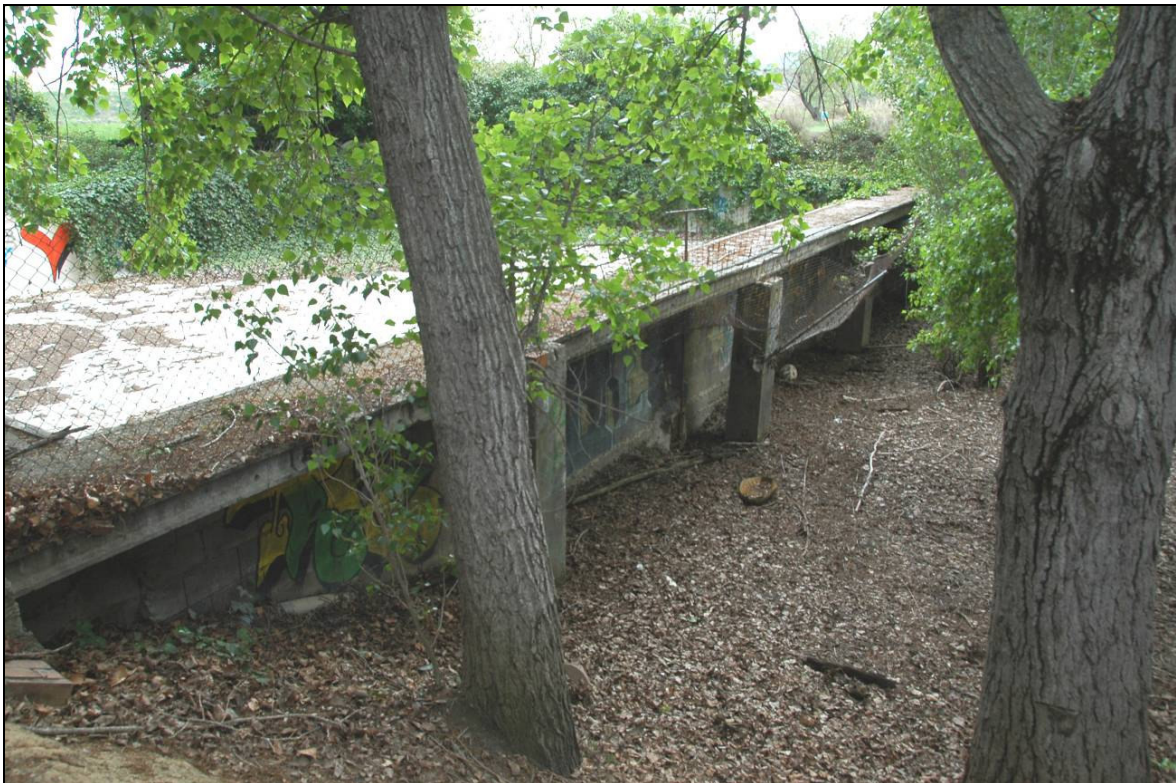
B: Piscina, vista des del nord
