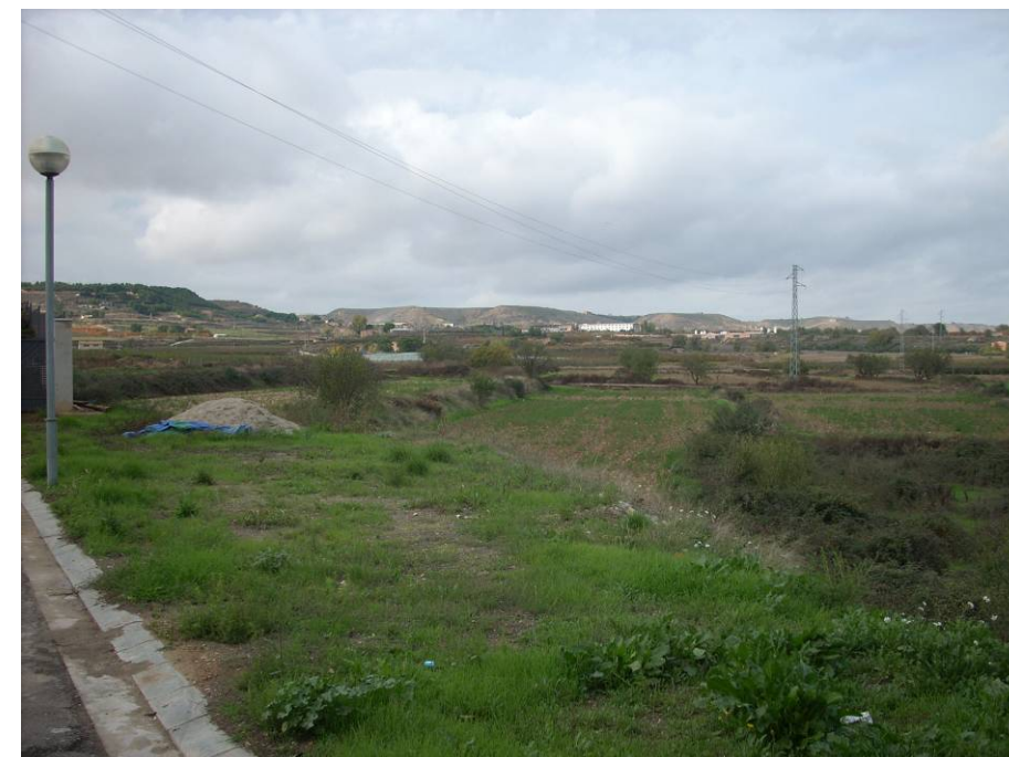
FOTO 47. Punt d'inici de la prolongació de la rambla. Vorada i rigola a demolir.
