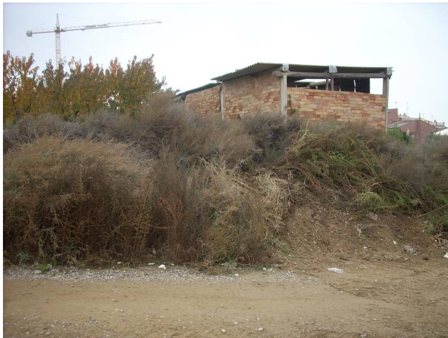
FOTO 96. Façana posterior de l'anterior edificació.
