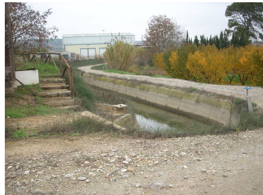
FOTO 107. Inici de la canalització del canal de Pinyana (tram de 60 m).
