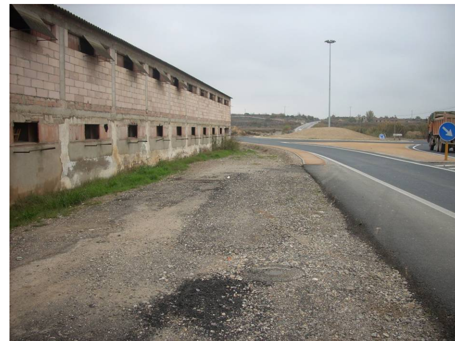
FOTO 111. Antiga granja a demolir, per la definició de la zona verda, lateral a la N-230.
