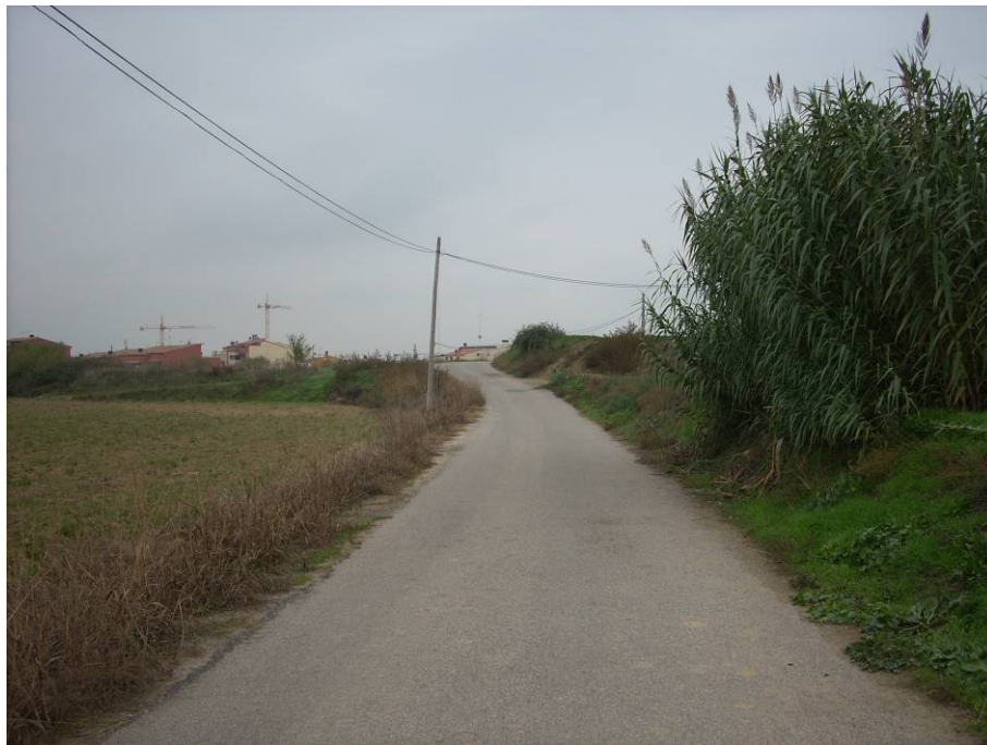
FOTO 72. Tram final del camí d'Albelda afectat per les obres, en sentit sud.
