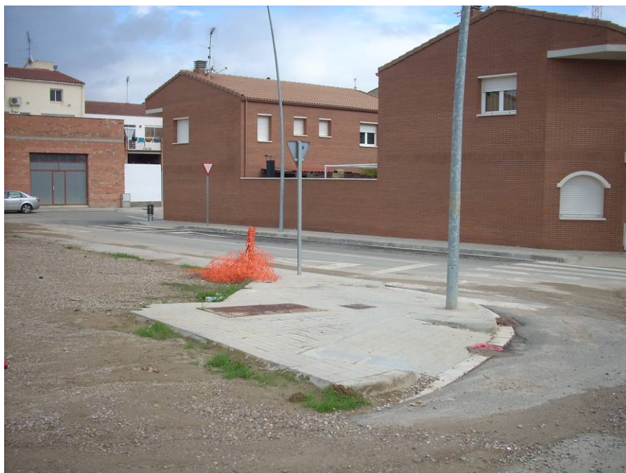
FOTO 25. Detall de l'entroncament entre el c/ Verge del Pilar i el c/ Estels, en sentit nord.
