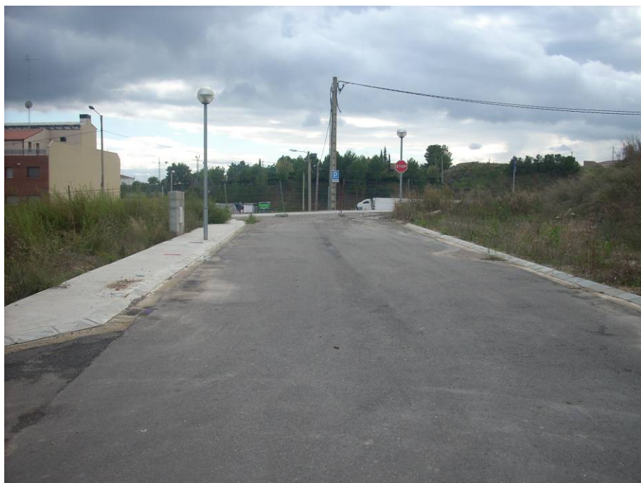
FOTO 41. Detall del tram existent de l'av. Rosers. Al fons Camí d'Almacelles.
