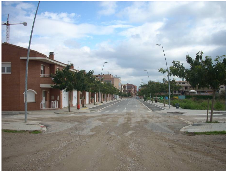
FOTO 24. Estat actual de l'acabament del carrer Verge del Pilar.
