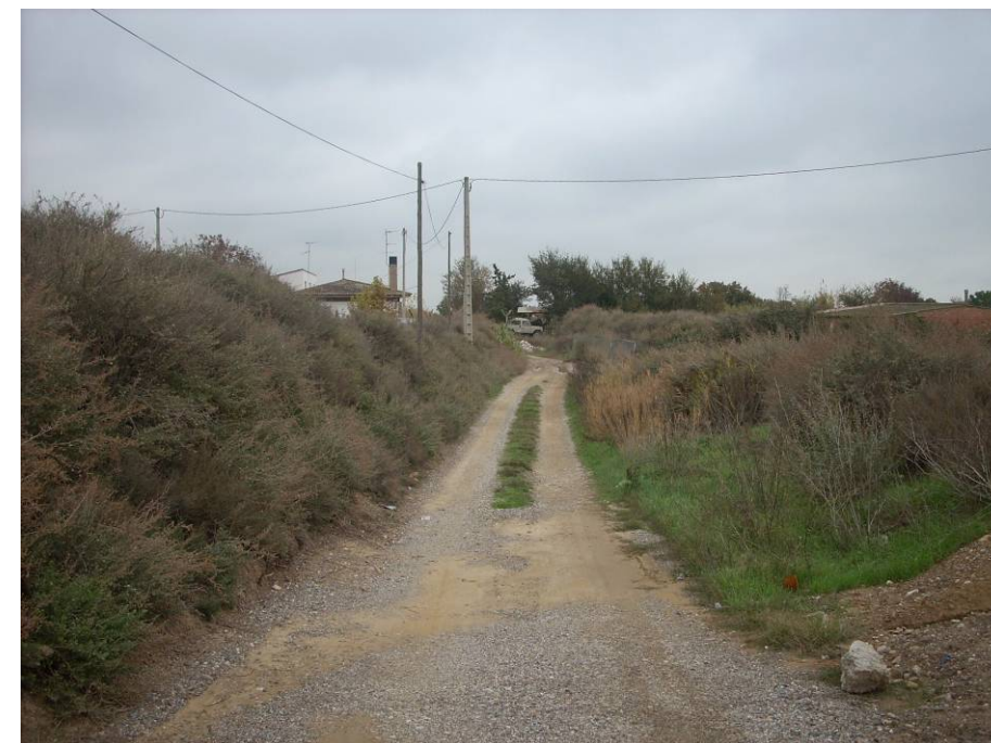
FOTO 103. Vial anterior, que serà pavimentat i permetrà arribar al carrer 14.
