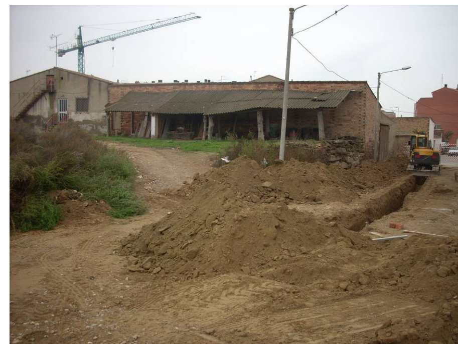
FOTO 95. Edificació a demolir, per la implantació del nou tram de carrer de la Lluna.
