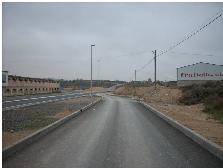
FOTO 101. Continuació de foto anterior. Al costat, línia telefònica a retirar.
