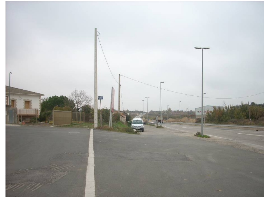
FOTO 118. Vista general de la N-230, futura zona verda lateral i entroncament amb carrer de Francesc Macià.
