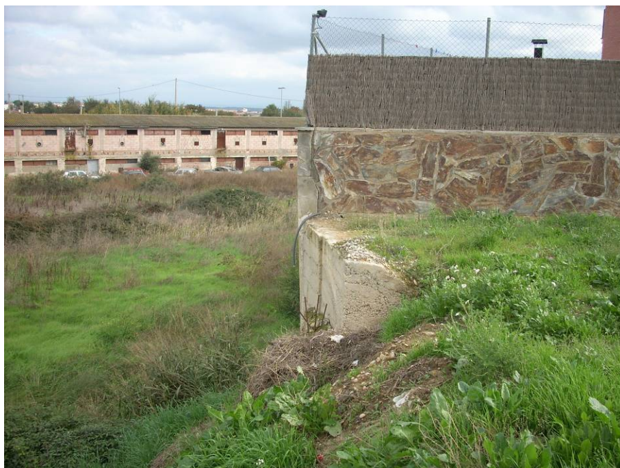
FOTO 49. Detall del mur de contenció, del tram final de la rambla de Girona.
