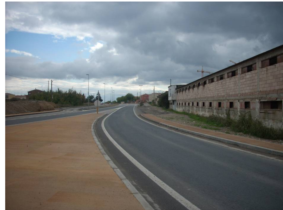
FOTO 18. Continuació de la N-230, en sentit Lleida, un cop superada la rotonda. A la dreta, antiga granja d'aviram a demolir.
